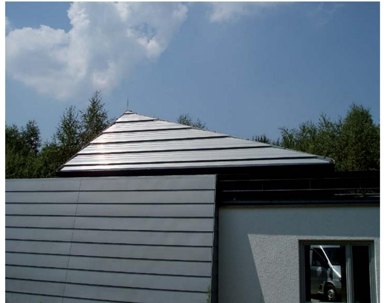
1114 Das Cabrio-Schiebedach 650 x 545 (B x T) gibt die Öffnung für das Teleskop der technischen Universität Dresden frei. Das etwas exotisch gestaltete Cabrio-Dach berücksichtigt die Einstellwinkel des Teleskops.
