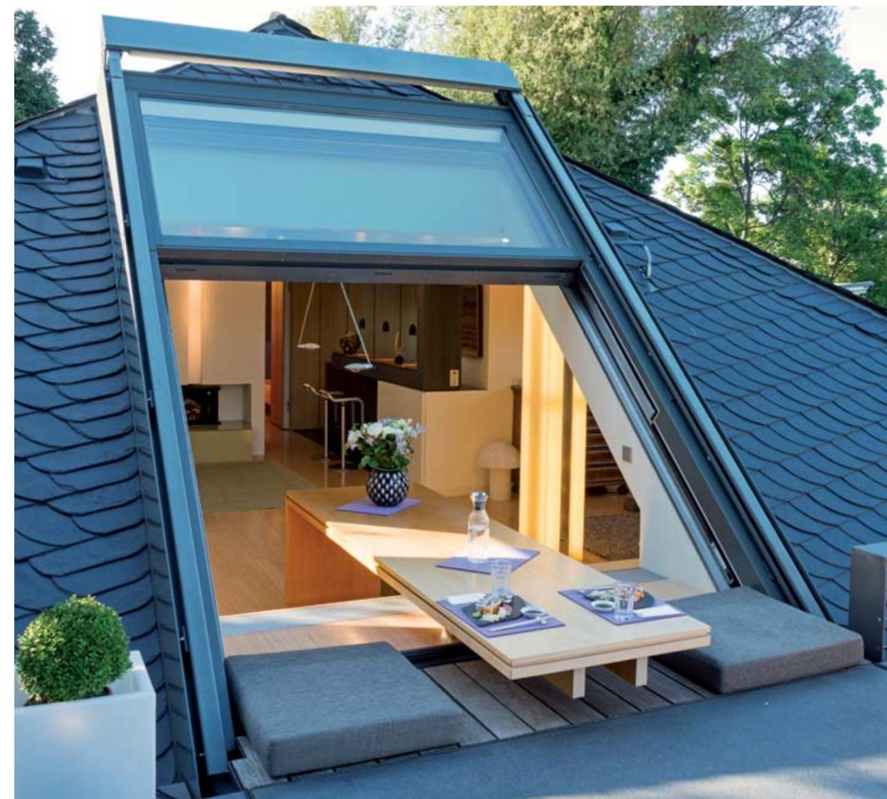
925 Dieser moderne Umbau eines Dachgeschosses in Würzburg gefällt durch seine geschmackvolle Gestaltung und die technischen Highlights wie dem 3-teiligen OpenAir-Dachschiefefenster 280 x 390 cm (B x H) und den bis auf die Dachterrasse herausfahrbaren Esstisch.
