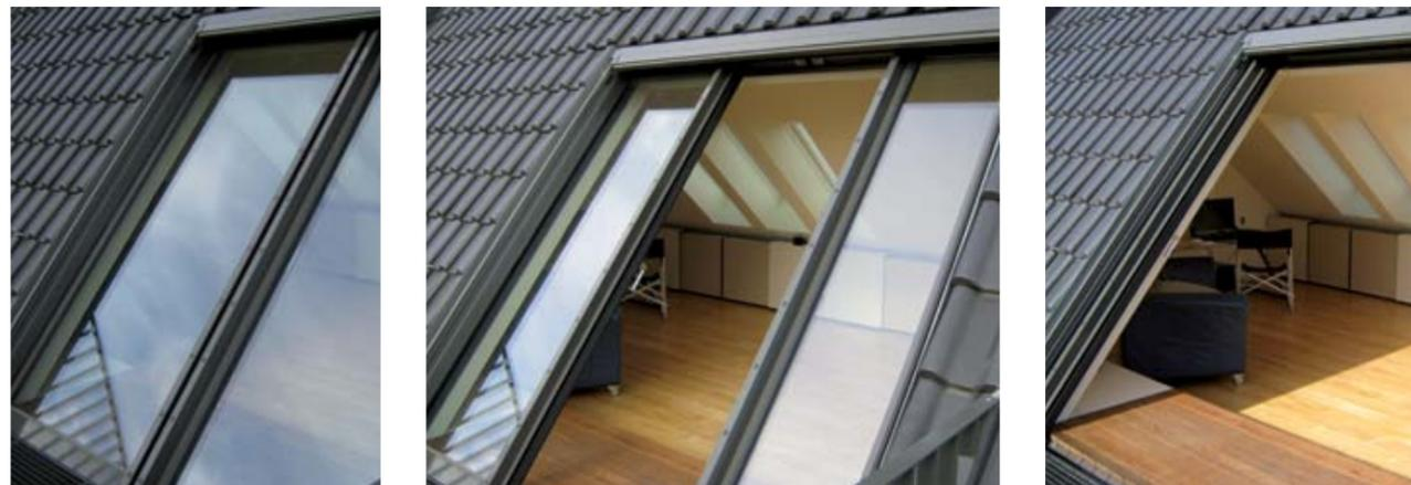
1106 4-teiliges Panorama-Dachschiebefenster Typ AH. Die Schiebeflügel fahren in die Einschubtaschen unterhalb der Bedachung. Optisch ein unauffälliger, flächenbündiger Einbau; mit Markise.
