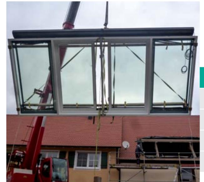
Bei der Fenstermontage kommt oft der Autokran zum Einsatz.
