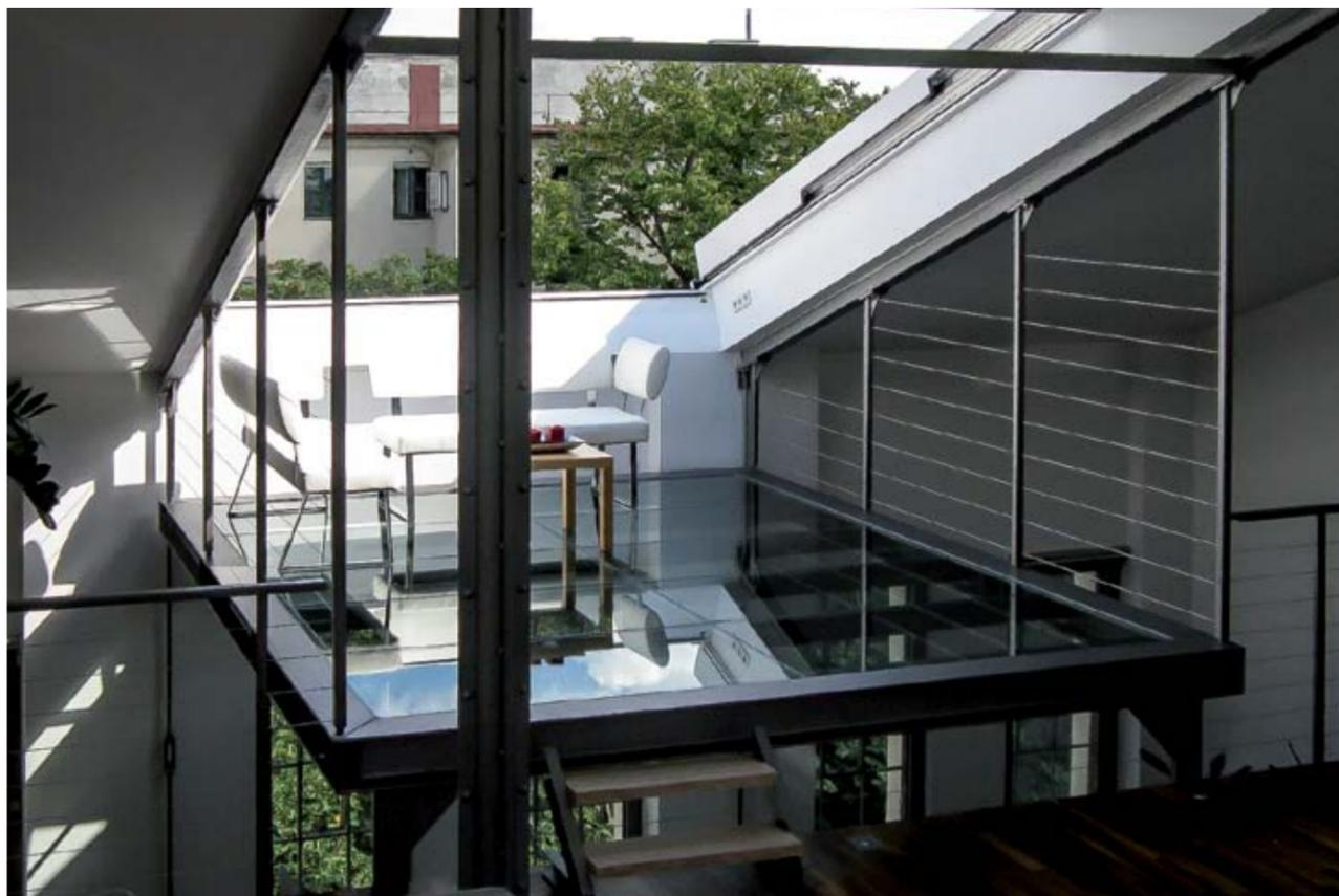
1055 Schwebende Dachterrasse in Wien mit großer Dachöffnung durch 4-teiliges OpenAir-Dachschiebefenster ca. 360 x 580 cm (B x H) und Glasboden zur Belichtung des Esszimmers im Untergeschoss.
